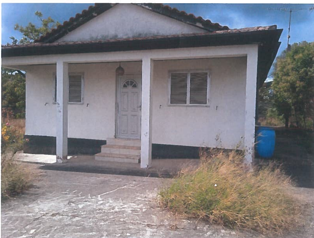
Fotografia 5 – Vista parcial da habitação, de cujo logradouro a parcela faz parte
