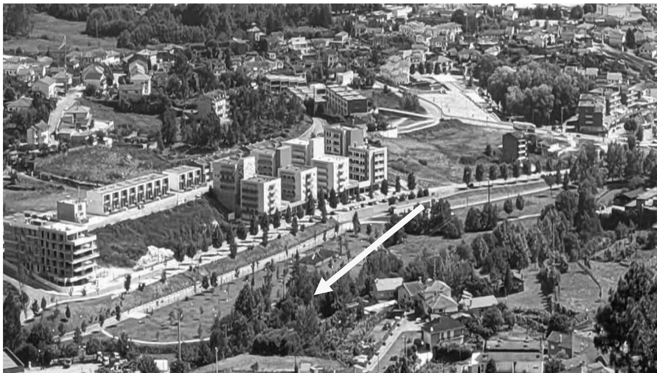
Fig. 2. Vista do posicionamento da parcela de terreno, em relação ao Parque Urbano do Pontido.
