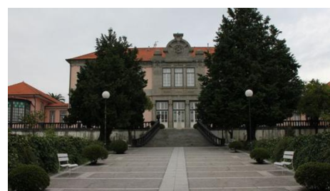
Figura 14 | Dependência do Hospital da Misericórdia da Póvoa de Lanhoso, designada por “Portaria Principal”
