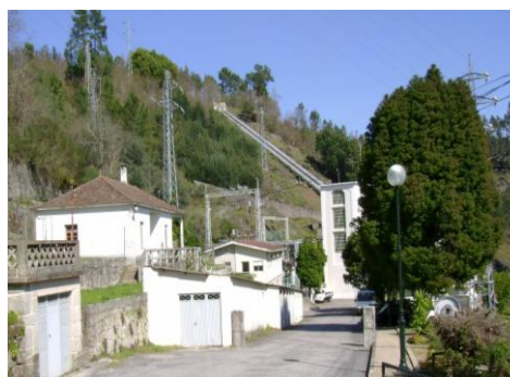
Figura 25 | Central hidroelétrica do Ermal
