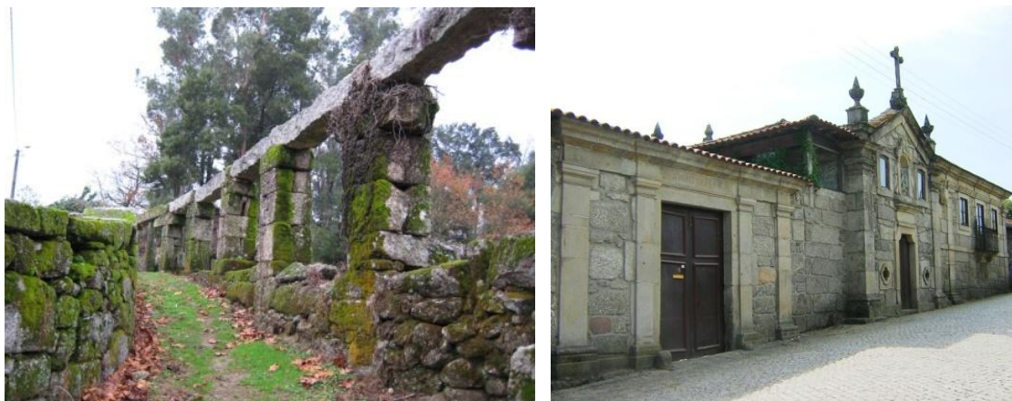
Figura 24 | Aqueduto dos Caleiros (esquerda) e Casa do Ribeiro (direita)
